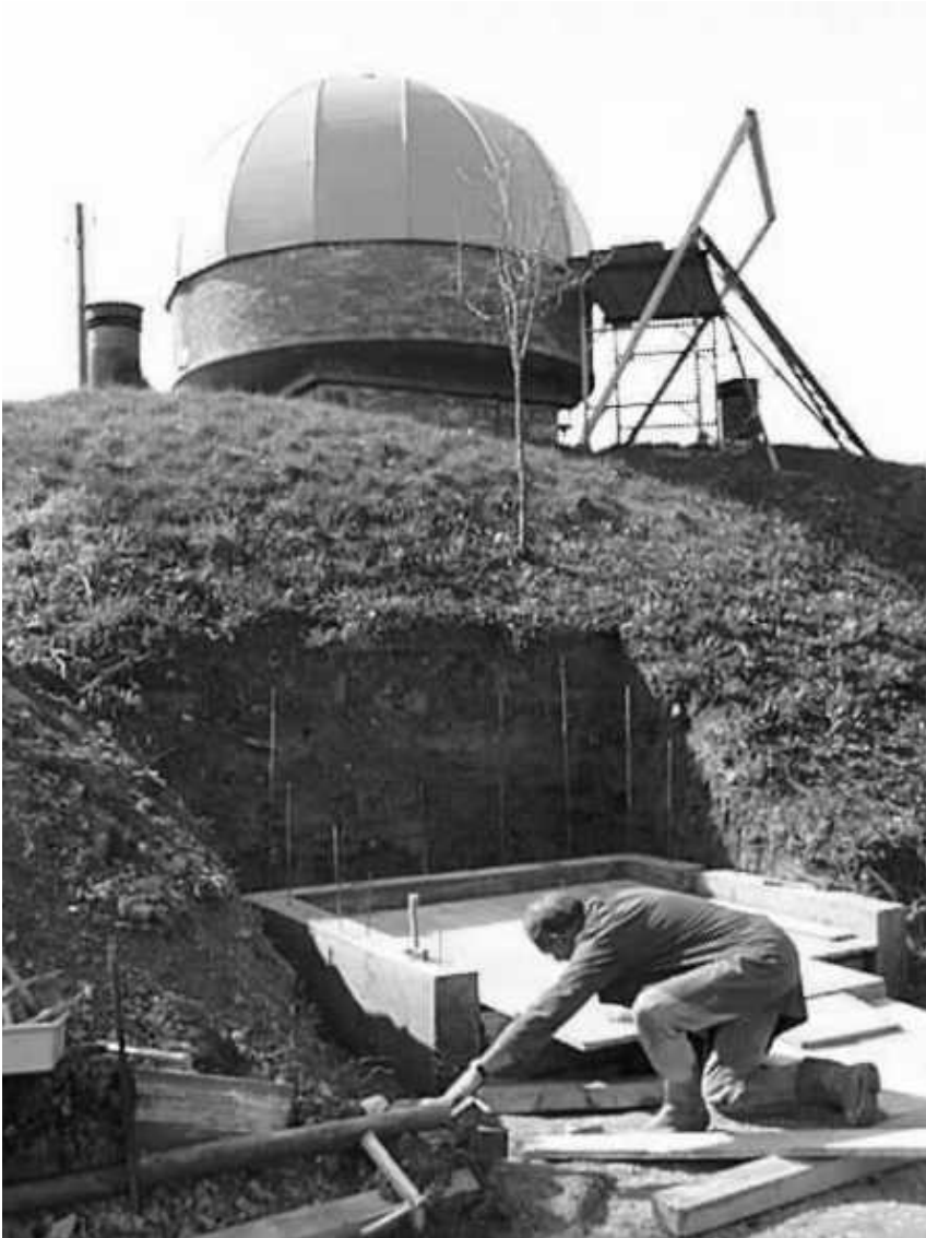
Ein solides Fundament für kleine und grosse «Geschäfte» im Entstehen (wb)
