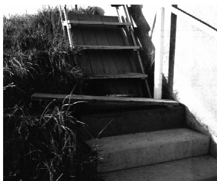
Der frischbetonierte oberste Tritt (wb)
