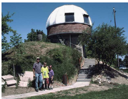
Der Zugangsweg mit Treppe (WB)
